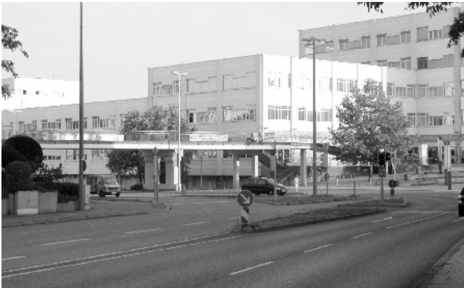
Den Fußgänger wieder zurück auf die Erde holen - Ebenerdiges Querens anbieten, Foto: Stadtverwaltung
